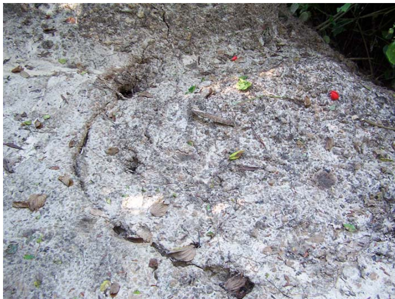
Figura 52 – Aterro com trincas de rompimento.
