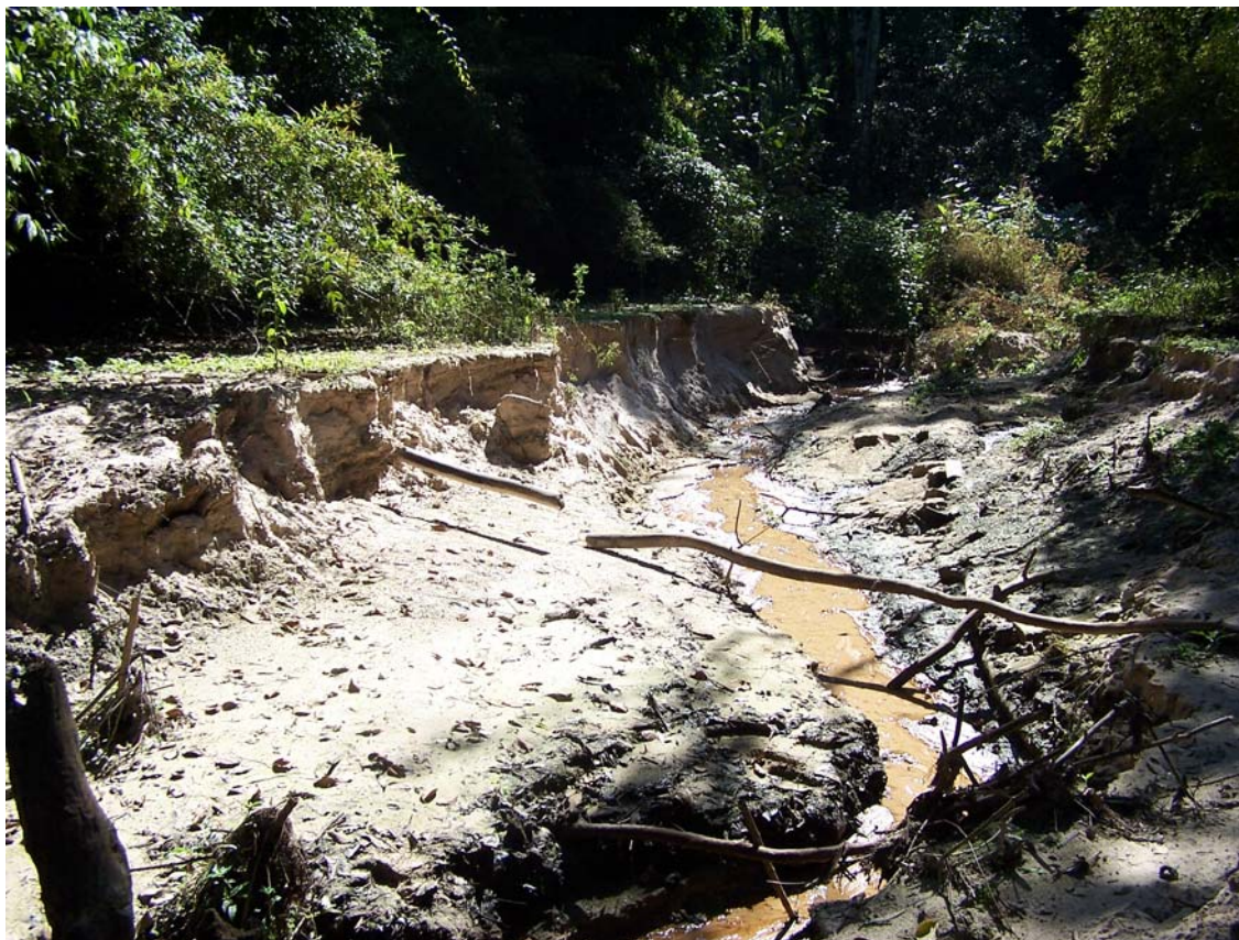
Figura 59 – Assoreamento de Reservatório (dos Patos) que levou ao rompimento do dique (Figura 60).
