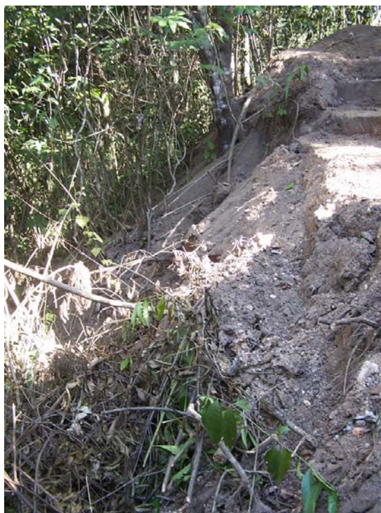
Figura 51 – Aterro executado para construção de trilha. Observar materiais lançados na encosta é que serão movimentados nas próximas chuvas.
