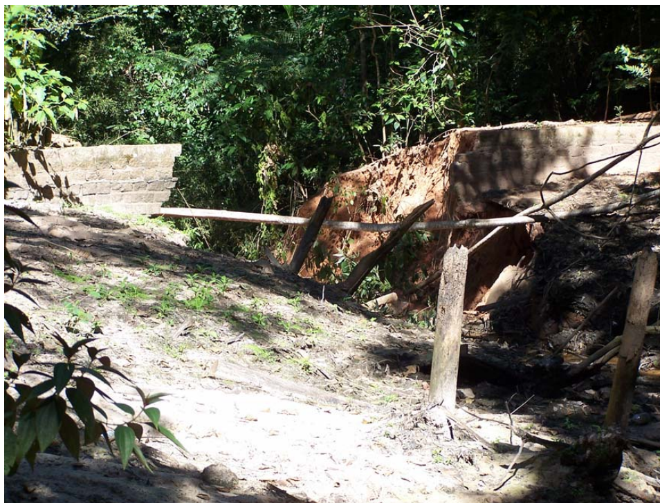
Figura 60 - Rompimento do dique do Reservatório dos Patos.
