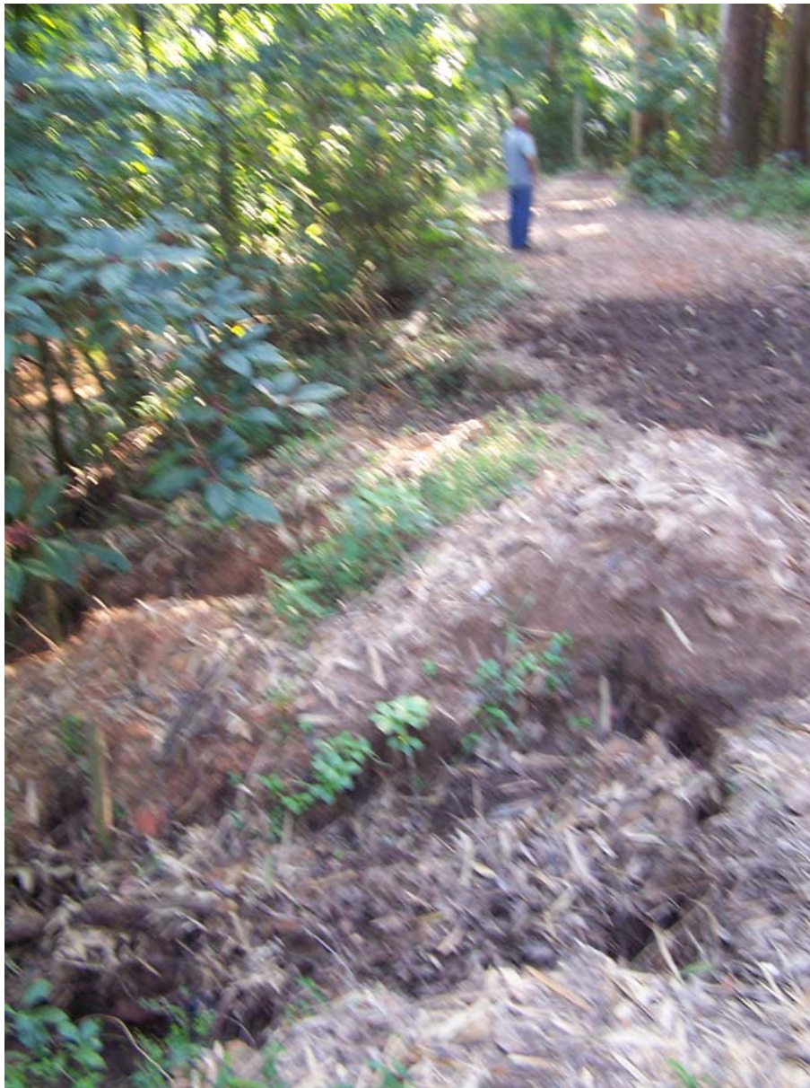
Figura 65 - Erosão e instabilidade de aterro lançado em encosta.
