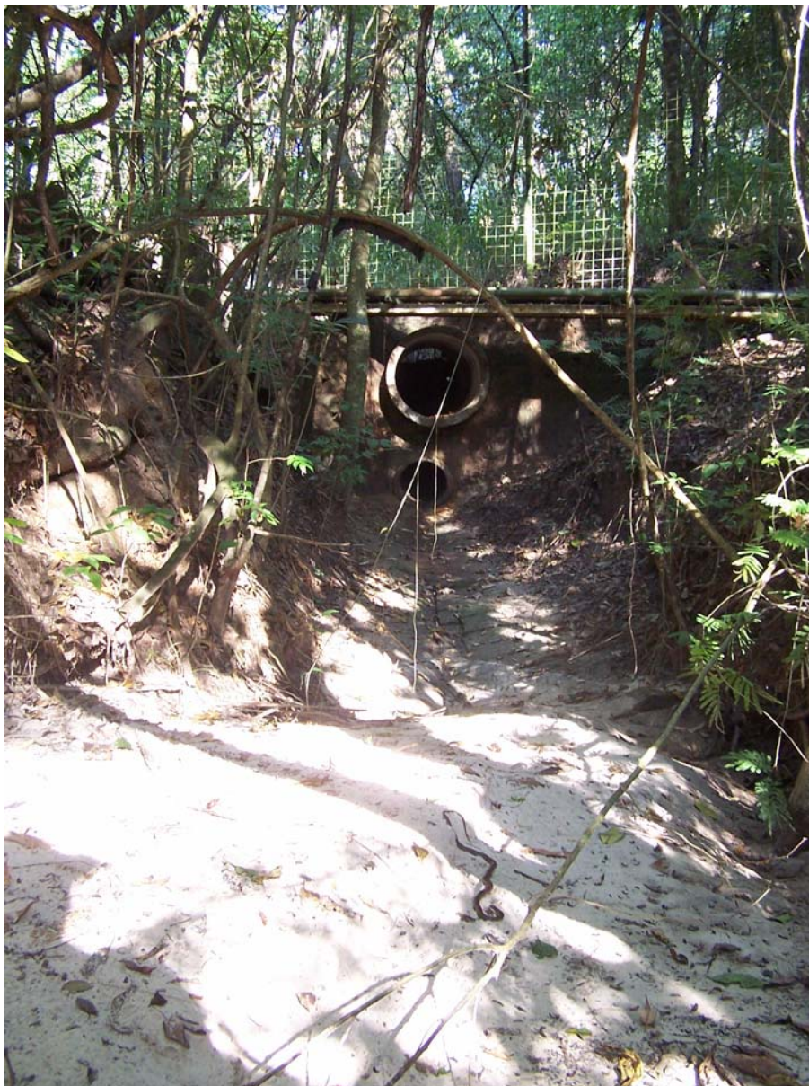
Figura 71 – Tubulações de águas pluviais direcionadas para as encostas do parque. Observar processo erosivo e depósito de sedimento.
