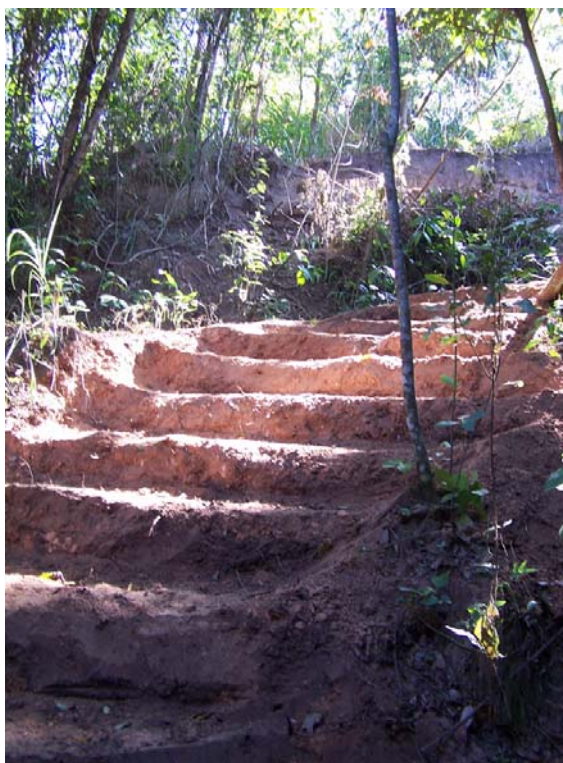
Figura 47 – Execução de trilhas destruindo a camada de materiais orgânicos superficial, concentrando águas superficiais e propiciando o aumento do processo erosivo.
