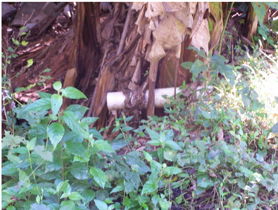
Figura 50 – Lançamento de águas servidas diretamente sobre a encosta.
