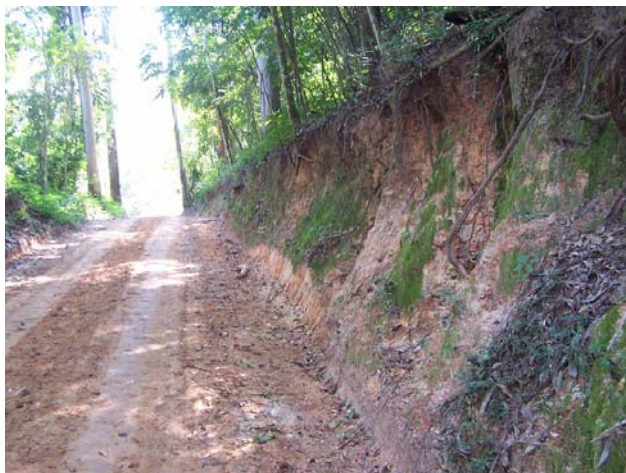
Figura 46 – Processo erosivo e instabilidade em corte de acesso para veículos.
