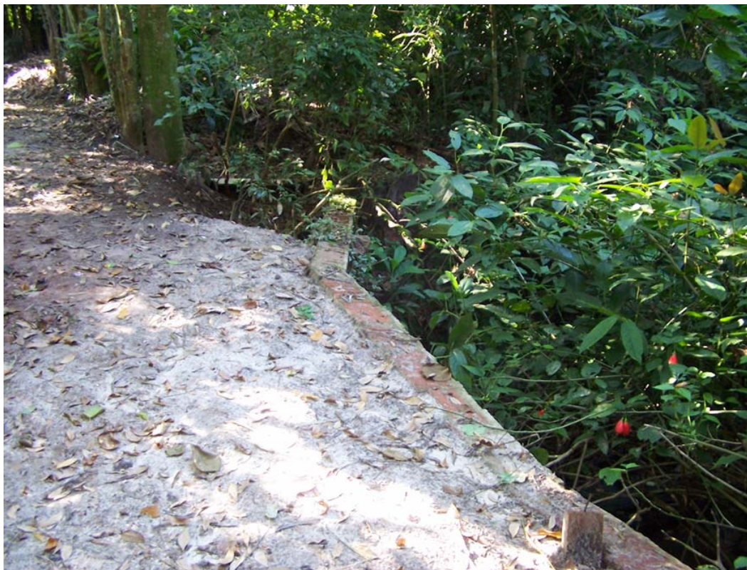
Figura 62 - Observar estrutura de alvenaria já rompida (observar inclinação da porção final).
