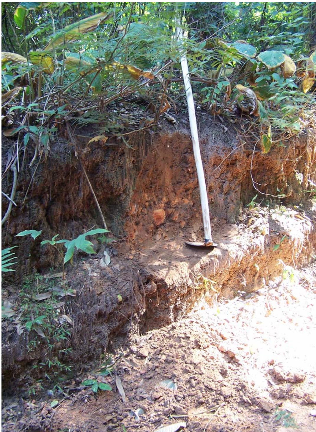
Figura 45 – Diferentes níveis de posicionamento das trilhas em função das necessidades de manutenção. Cada vez mais há necessidade de aprofundamento do leito devido ao processo erosivo e instabilidade dos cortes.
