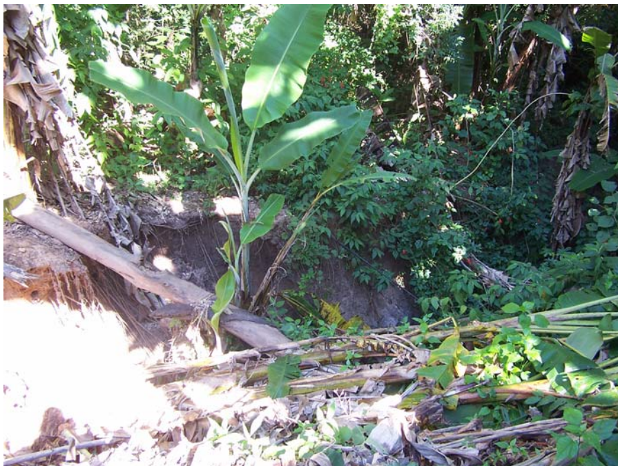
Figura 56 – Erosão de aterro e materiais inconsolidados da encosta devido ao direcionamento de águas superficiais.
